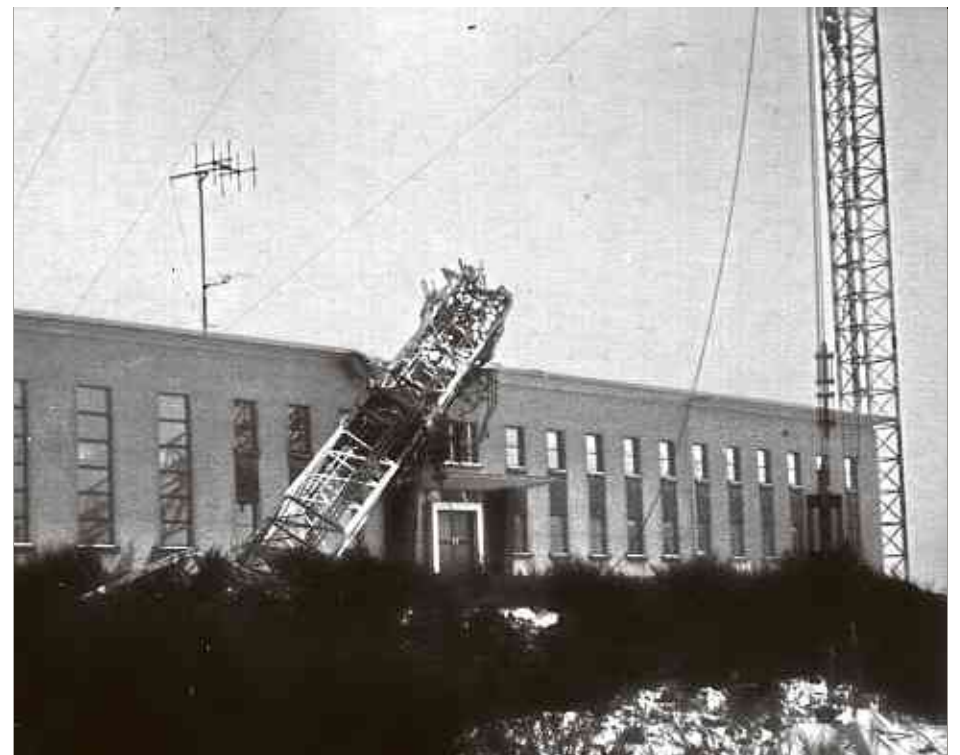
1969 stürzte die Spitze eines Sendemastes in Marnach auf das danebenliegende Kontrollgebäude.
